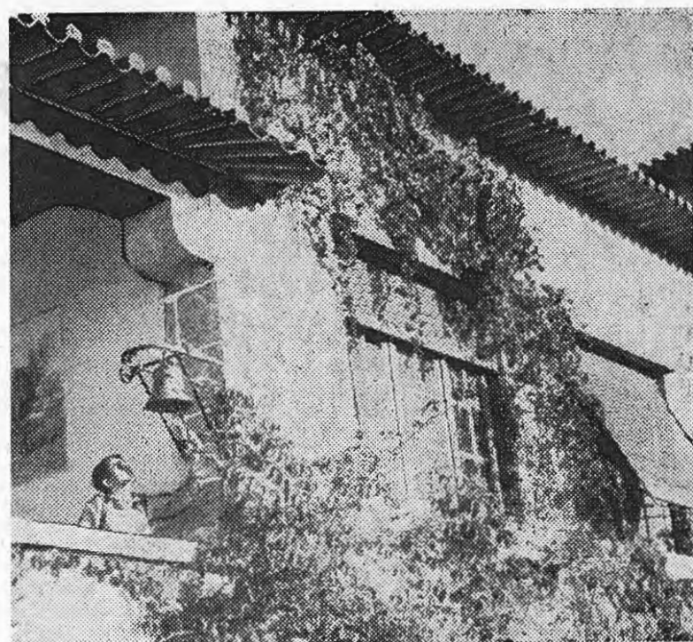
A Casa-Mãe, rendilhada de trepadeiras. A «Câmara» da Cidade dos Rapazes, onde a sineta dá ordens!
